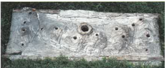
►► Afdekkap (binnen- en buitenzijde) waarin in de hoogste zone zowel een giettrechter als ontluuchtingsopeningen voorzien zijn (Epitaaf vzw, fonds Beernaert. Foto L. Declercq)
