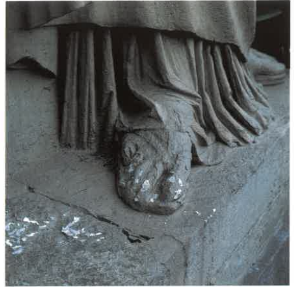
▲ Detail van het Pleyel-monument met afstoting van de verflaag wellicht door zoutuitbloeiingen (foto Lode De Clercq)
