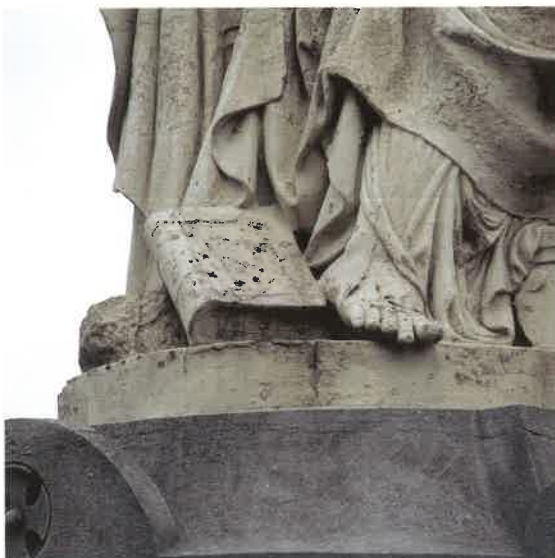
▼ Ghémar grafmonument. Aantasting van een met kalkmortel aangevulde zone (foto Lode De Clercq)
