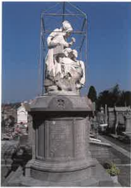
▲ Aanbrengen winterbescherming rond het Ghémar monument (Laken) in 1990: metalen frame bewaard in Atelier Salu (foto Lode De Clercq)
