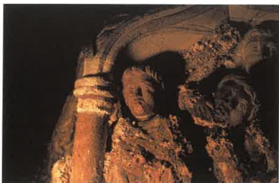
◀ Consoles van de gevel van het Leuvense stadhuis, verwijderd bij de restauratie in 1857 (foto Marjan Buyle)
