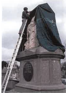
▲ Aanbrengen winterbescherming rond het Ghémar monument (Laken) in 1990: aanbrengen dekzeil (foto Lode De Clercq)
