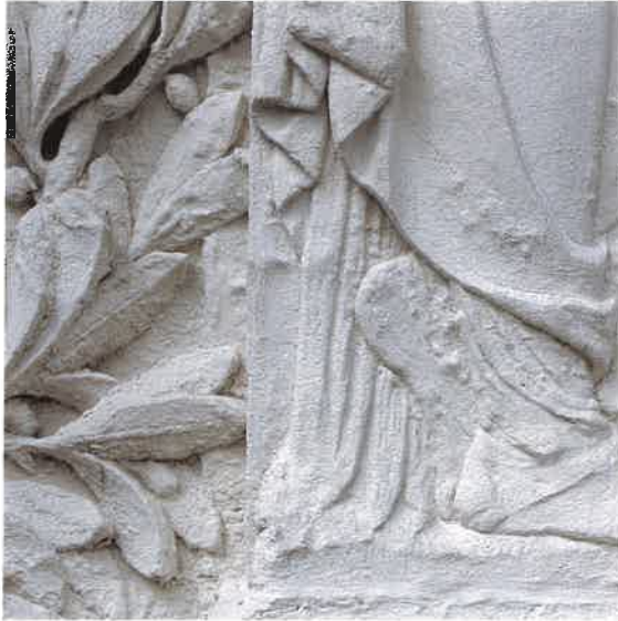
► Suys monument te Laken. Loskomen van de verflaag en de consolidaties (foto Lode De Clercq)
