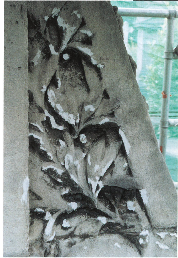
▶ Opvullen met kalkmortel (foto Jacques Vereecke)
