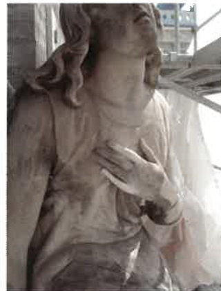
◀◀ Reconstructie met plaaster van de ontbrekende vingers van de Engel van het Martelaarschap en vervanging door nieuwe vingers uit wit Carrara marmer (foto's Regie der Gebouwen)
