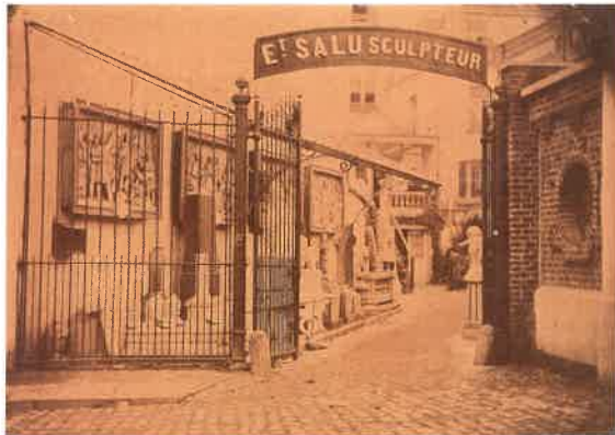
► De plaasteren modellen voor de bas-reliëfs, in het beeldhouwersatelier Ernest Salu, Laken, omstreeks 1885 (foto Epitaaf vzw, fonds E. Salu)
