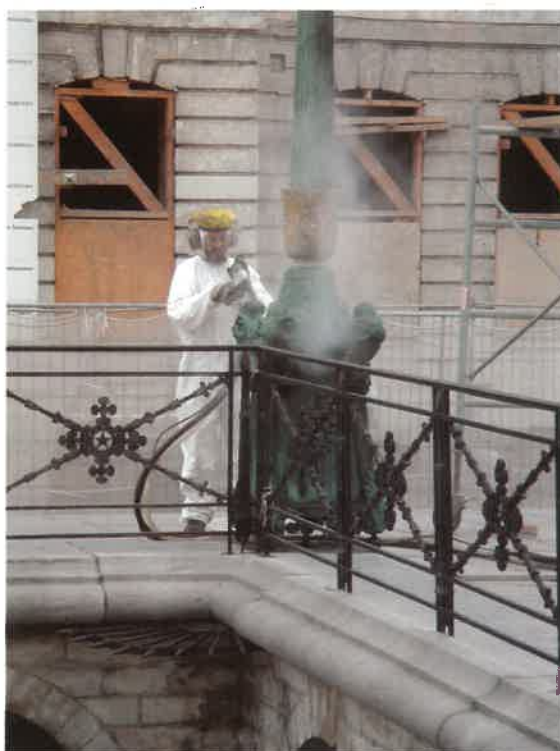
▼ Reiniging van de bronzen lantaarns met de techniek van droogijstralen (foto Regie der Gebouwen)
